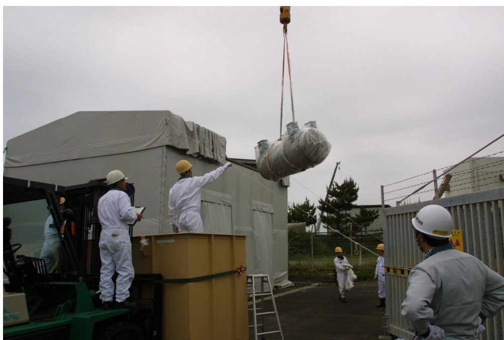
図 3.4.3-9 平成 18 年度 大型廃棄物の取り出し作業
