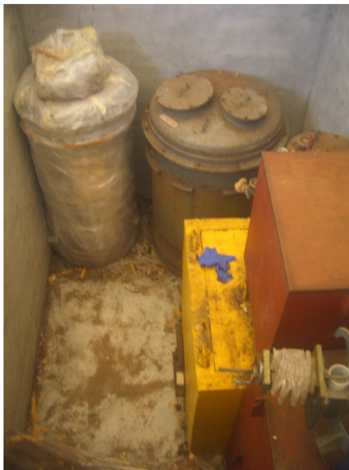
図 3.4.3-8 平成 18 年度 取出し作業終了後の保管廃棄施設内の状況
