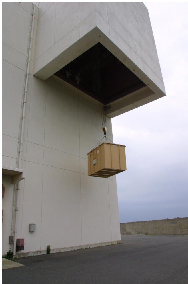
図 3.4.3-10 平成 18 年度 大型廃棄物の搬入作業
