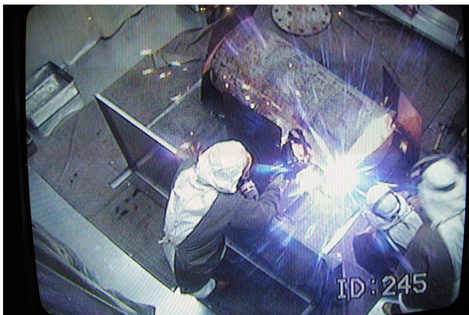
図 3.4.3-11 溶断作業状況
