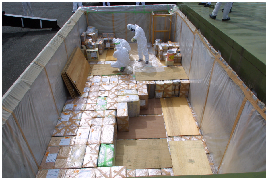
図 3.4.3-2 平成 17 年度下期 排気フィルタ取出し作業開始前の保管廃棄施設内の状況
