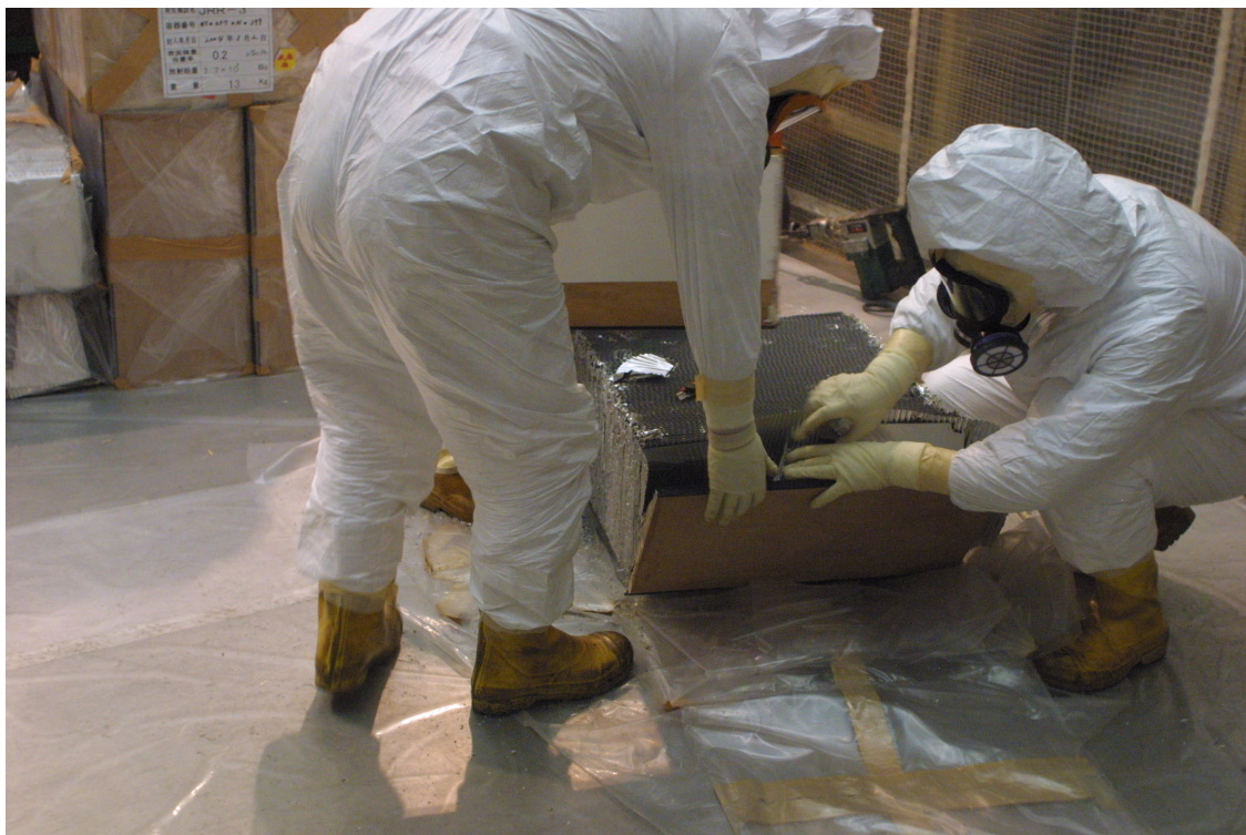
図 3.4.3-4 HEPA フィルタの木枠とメディアの分離作業
