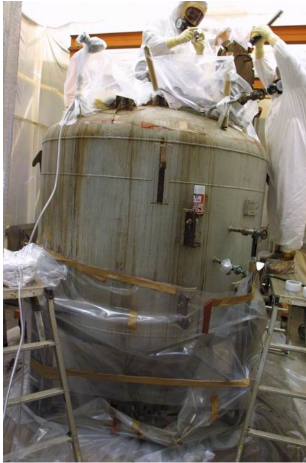
図 3.4.3-12 槽類の内部確認作業
